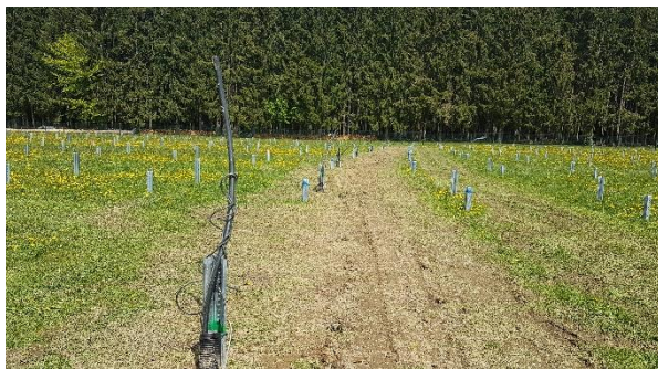
Abbildung 3: Verfüllter Kabelgraben
