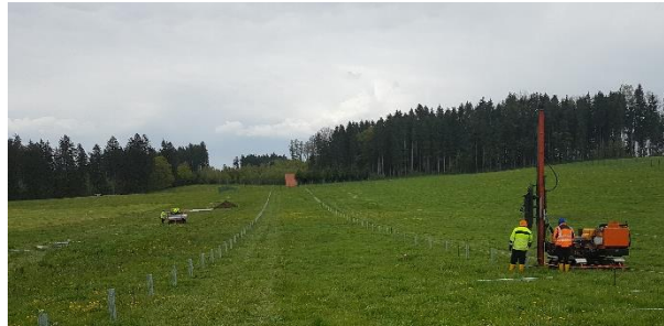
Abbildung 2: Hydraulikramme auf Ketten
