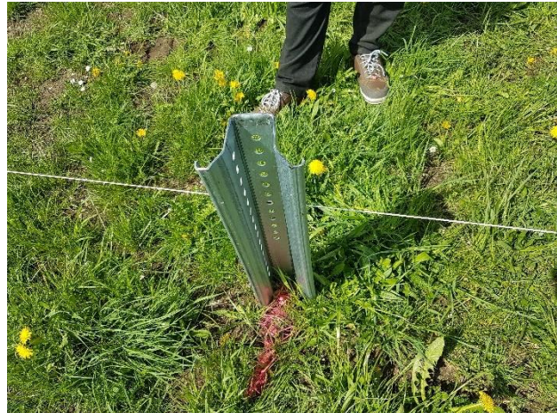
Abbildung 5: Rammfundament
