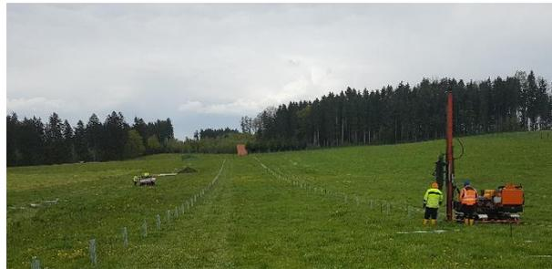
*Abbildung 4: Hydraulikramme auf Ketten*
