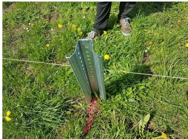
Abbildung 7: Rammfundament
