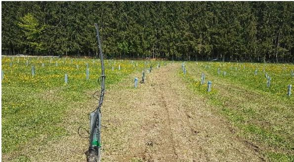
Abbildung 5: Verfüllter Kabelgraben
