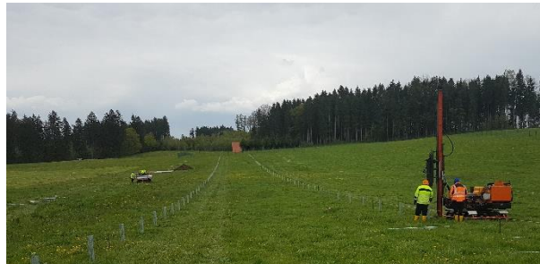
Abbildung 3: Hydraulikramme auf Ketten
