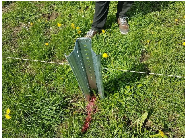
Abbildung 6: Rammfundament
