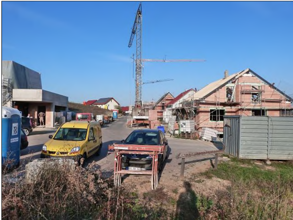
Abb. 3: Blick von Süden in den nördlichen Teil des Baugebietes, 15.10.2018
